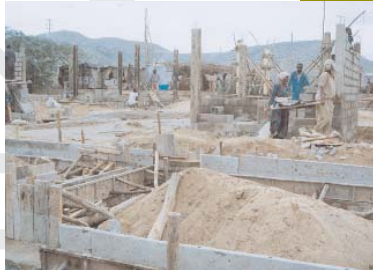
ቤተክርስቲያኒቷ የምታስገነባቸው 200 ቤቶች እያንዳንዳቸው ሳሎንና አንድ መኝታ ክፍል እንዲሁም መፀዳጃ ቤት ይኖራቸዋል። የቤቶቹ ግንባታ ከሦስት ወር እስከ ሦስት ወር ተኩል በሚሆን ጊዜ ውስጥ ይጠናቀቃል ተብሎ እንደሚታሰብም ተጠቅሷል።
