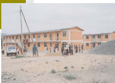
አያት የመኖሪያ ቤቶች ሥራ ድርጅት ለጎርፍ ተጎጂ ወገኖች ለ26 አባወራ የሚሆኑ ቤቶችን ገንብቶ ታህሳስ 23 ቀን 1999 ዓ.ም ለብሔራዊ ዕርዳታ አሰባሳቢ ኮሚቴው በማስረከብ የመጀመሪያው ሆኗል።
